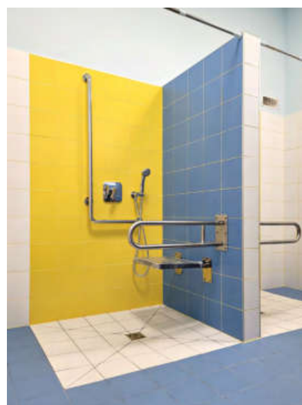
Ilustracja 81. Przykład pomieszczenia dostosowanego i przeznaczonego do przewijania dorosłych osób ze szczególnymi potrzebami (po lewej) oraz dostosowanego prysznica (po prawej), fot. Katarzyna Guratowska
