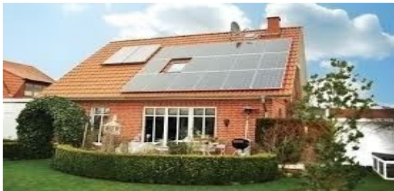
Rys nr VII.12. Przykłady instalacji ogniw fotowoltaicznych
