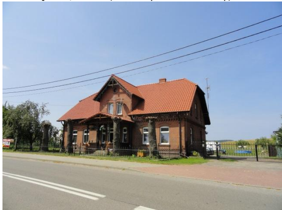
II. 42. Rębicz, szkoła (ob. budynek mieszkalny)
