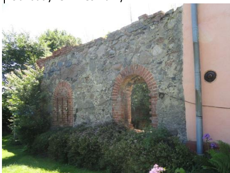
Il. 53-54. Ulkowy, gorzelnia ob. budynek mieszkalny
