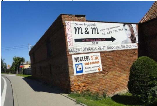
il. 59-60. Różyny, zajazd ob. budynek mieszkalny
