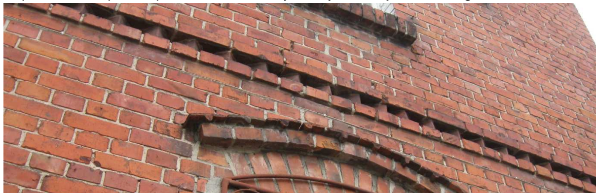
Fot. 10 Rolka w poziomie stropu nad parterem
