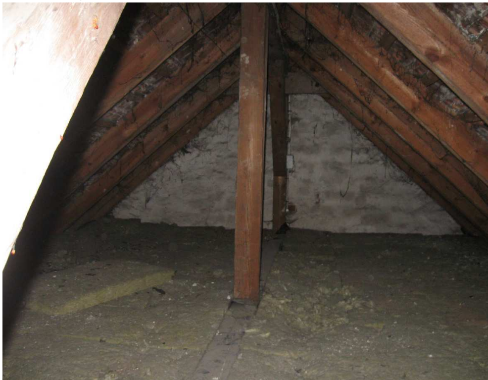
Fot. 6 więźba w jednym z segmentów
