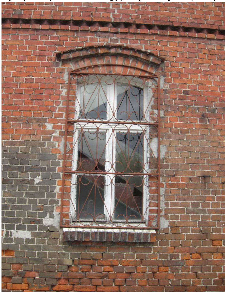
Fot. 9 Sklepienie łukowe ceglane nad oknem w poziomie parteru
