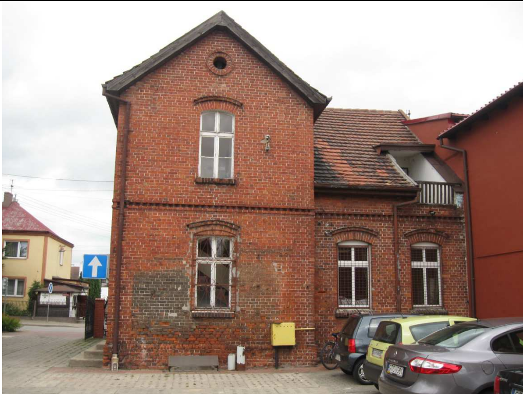
Fot. 2 Elewacja południowa istniejącego obiektu
