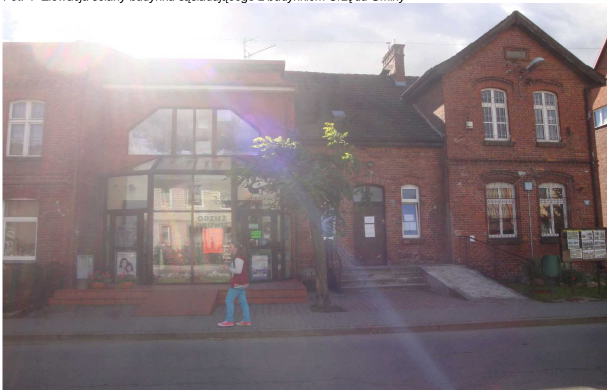
Fot. 5 Pierzeja ul. Pomorskiej
