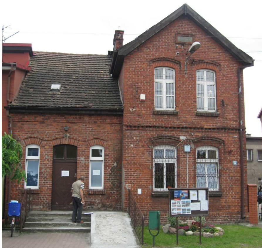
Fot. 1 Elewacja północna od ul. Pomorskiej istniejącego obiektu
