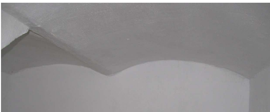
Fot. 7 Fragment sklepienia odcinkowego piwnicy
