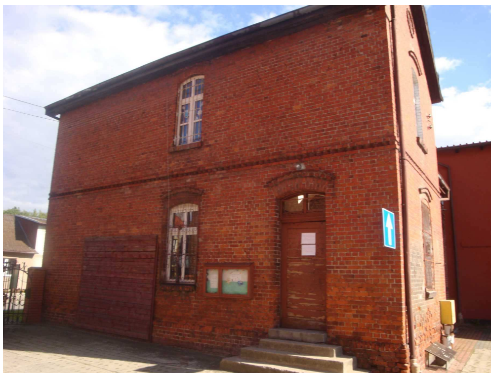
Fot. 3 Elewacja wschodnia istniejącego obiektu
