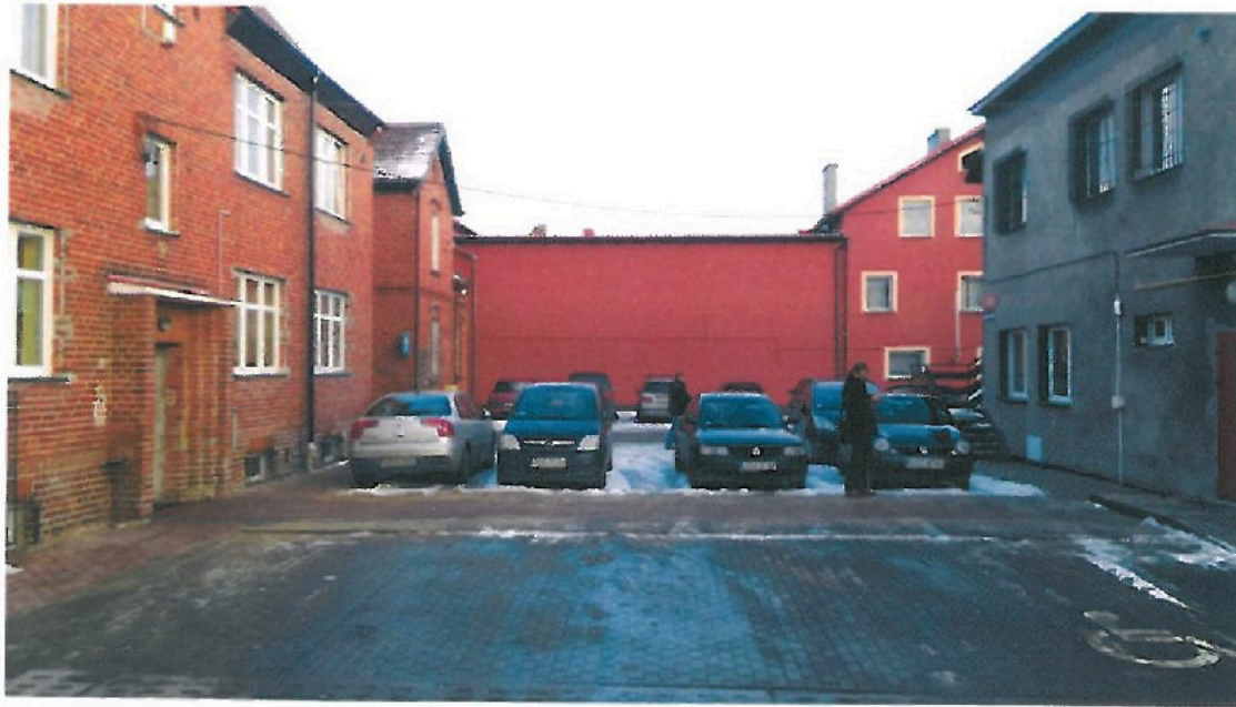
Fot. 4. Widok od strony zachodniej działki w miejscu projektowanego łącznika stalowego.
