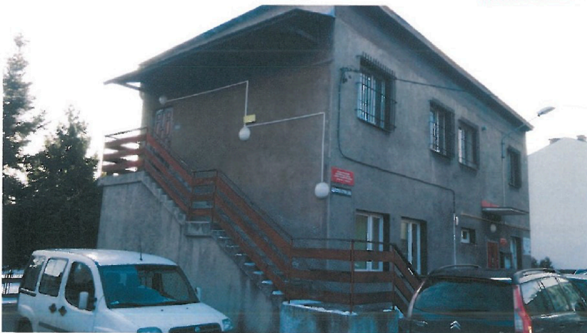
Fot. 2. Elewacja wschodnia ze schodami zewnętrznymi do rozbiórki
