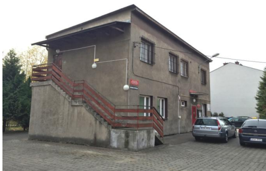
Widok elewacji frontowej N i szczytowej E
