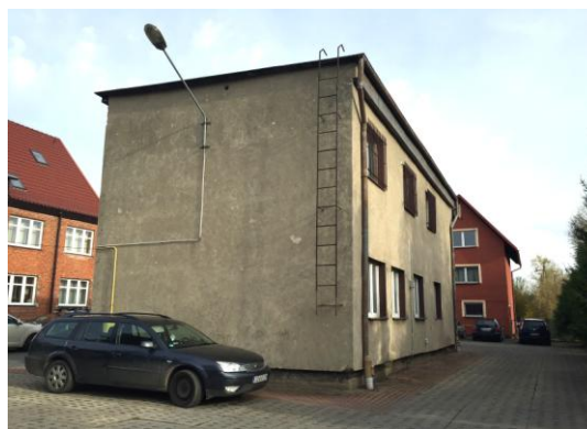
Widok elewacji tylnej S i szczytowej W
