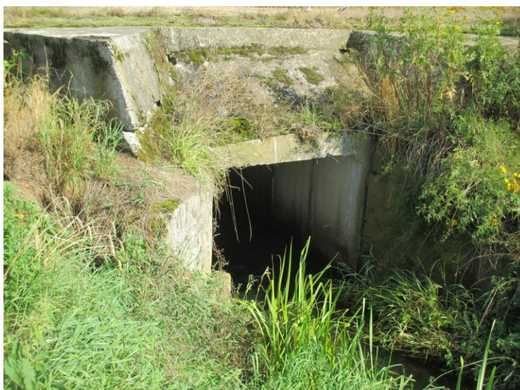
Fot. 1 Wlot przepustu
