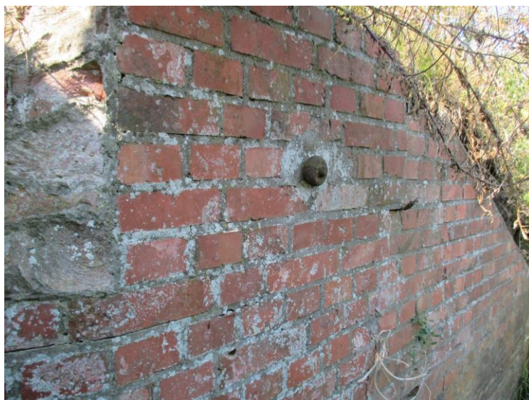
Fot. 6 Reper geodezyjny na ścianie kierunkowej – wylot, strona lewa
