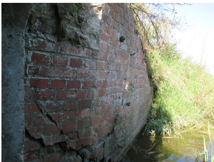
Fot. 5 Ściana kierunkowa przepustu – wylot, strona lewa
