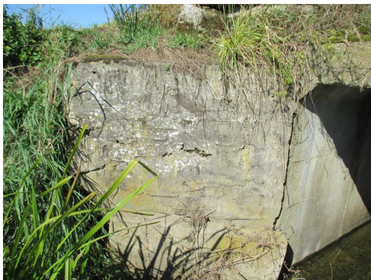
Fot. 3 Ściana kierunkowa przepustu – wlot, strona lewa
