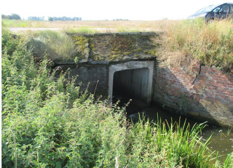
Fot. 2 Wylot przepustu
