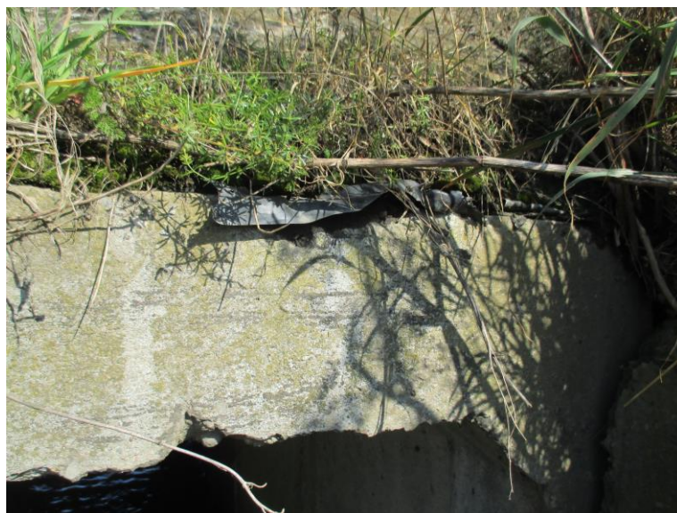
Fot. 12 Hydroizolacja stropu przewodu przepustu – folia PE
