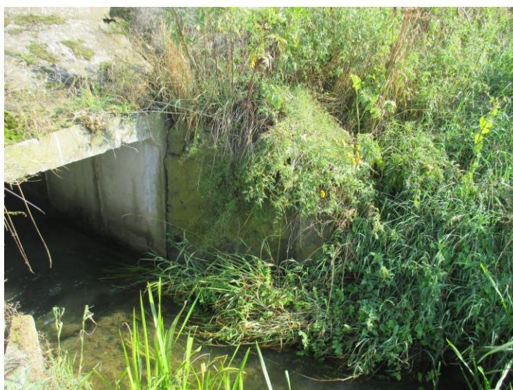
Fot. 4 Ściana kierunkowa przepustu – wlot, strona prawa
