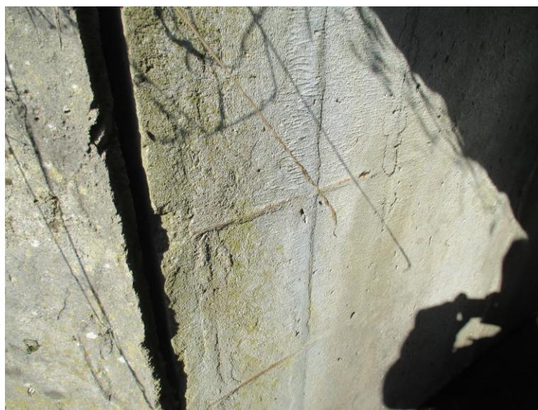
Fot. 13 Ściana przewodu przepustu – widoczne zbrojenie prefabrykatów
