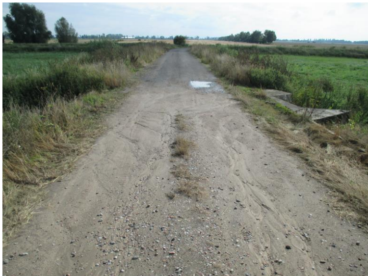
Fot. 0 Widok na drogę w rejonie przepustu – strona prawa wlot, strona lewa wylot
