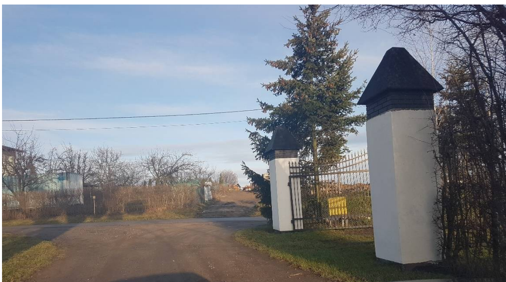
Zdjęcie nr 7 Odcinek B: – km 0+449 widok ogólny stanu istniejącego
