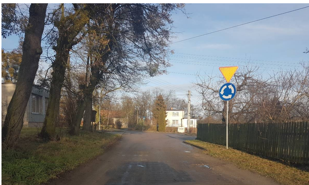
Zdjęcie nr 1 Odcinek A: – km 0+000 widok ogólny stanu istniejącego
