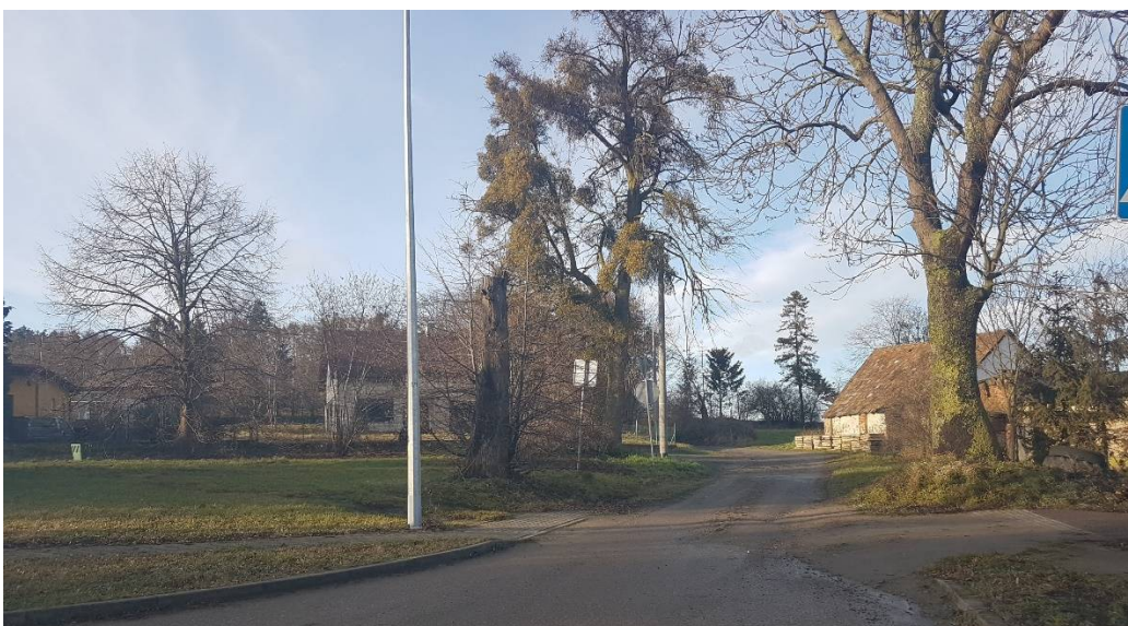
Zdjęcie nr 3 Odcinek B: – km 0+000 widok ogólny stanu istniejącego
