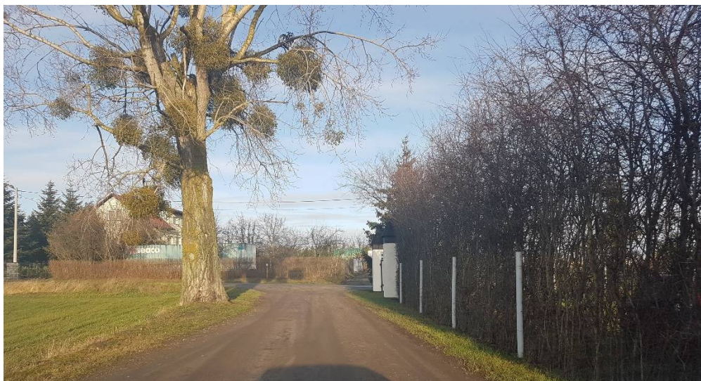
Zdjęcie nr 6 Odcinek B: – km 0+449 widok ogólny stanu istniejącego
