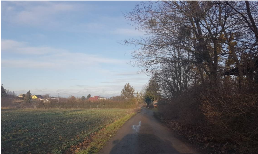
Zdjęcie nr 5 Odcinek B: – km 0+150 widok ogólny stanu istniejącego
