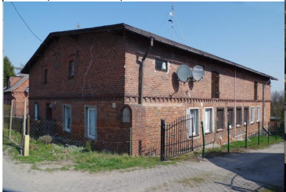
il. 64. Skowarcz, stajnia ob. budynek mieszkalny
