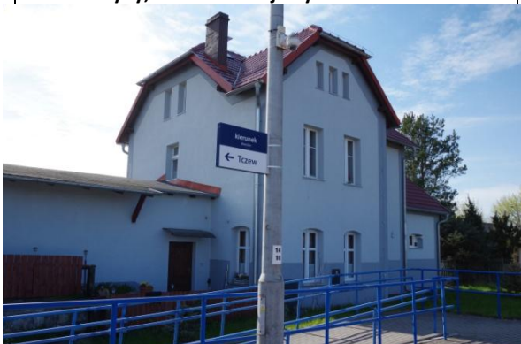
II. 50. Różyny, dworzec kolejowy
